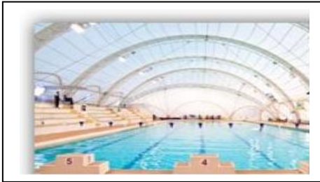
La piscine Jean Badet Avenue du Truc, 33700 Mérignac
